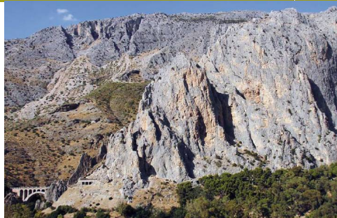
Los Tajos conocidos como Placas Frontales y uno de los puentes del ferrocarril de mayor belleza
